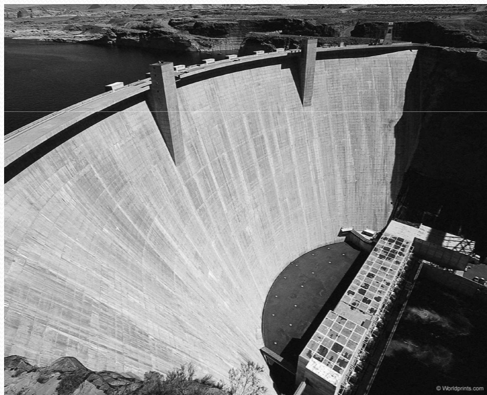
ГЭС с плотиной арочного типа.
