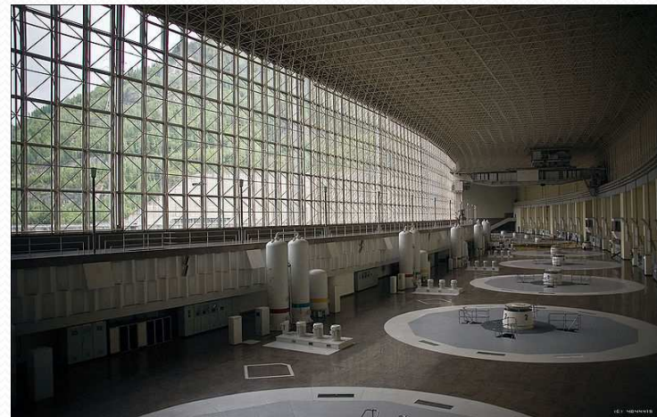
Машинный зал до аварии
