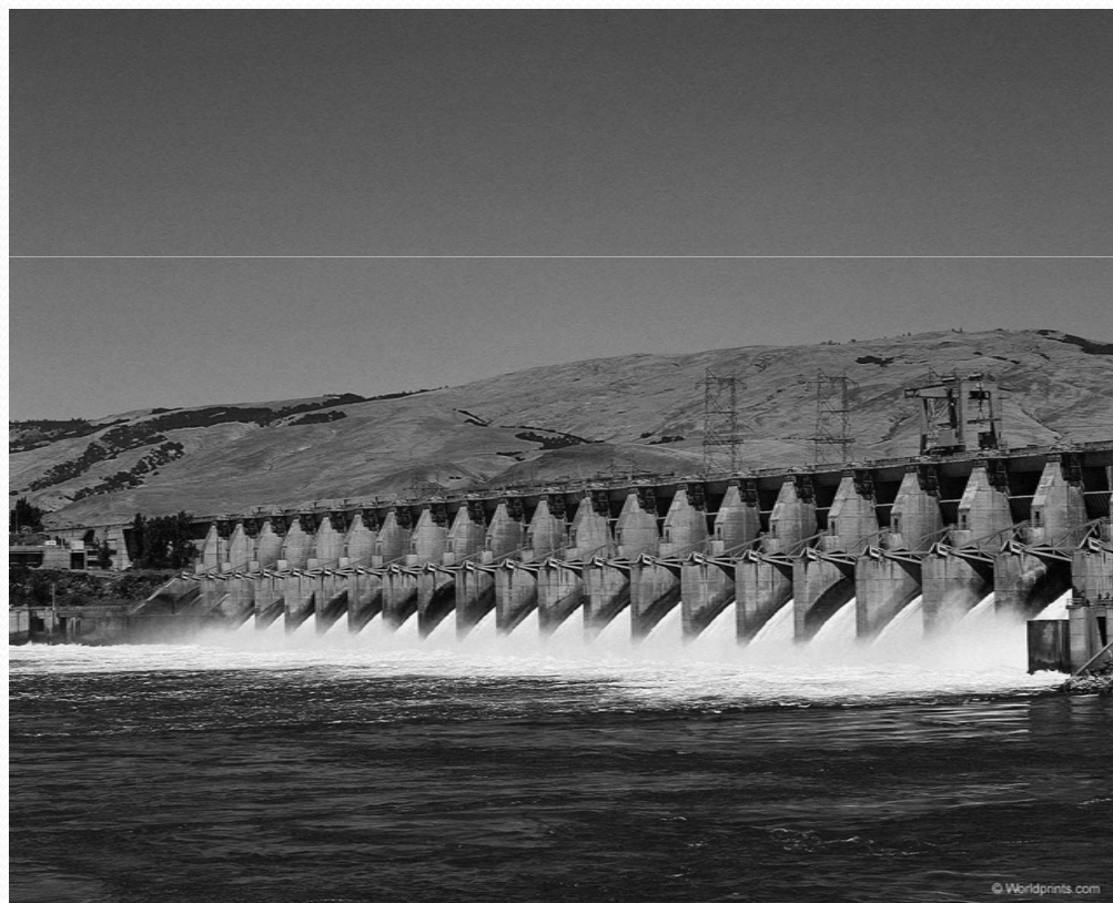
ГЭС с бетонной плотиной.
